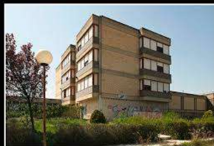
Antiguo colegio Lestonnac. La primera escuela estuvo ubicada en un local de la calle V. Huarte
