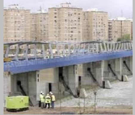
Azud, prueba de las compuertas
