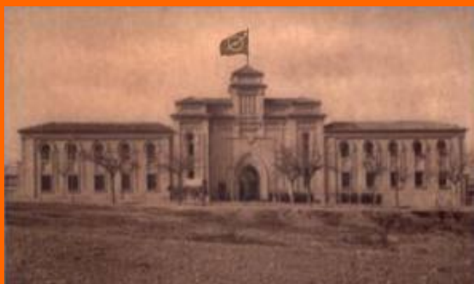
Fachada neomudejar de la antigua cárcel de Torrero
